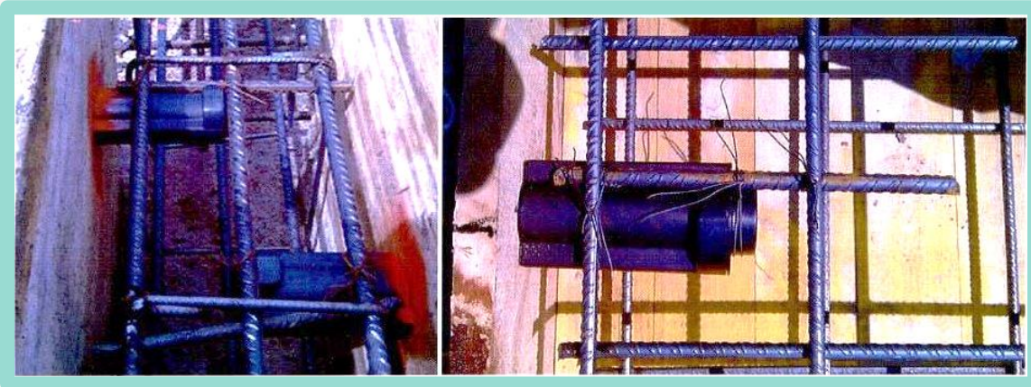
Figura 5. Colocación del Embebido JUSQ. Detalle de atado.
