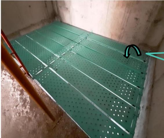
se deberá realizar como primera acción el retiro de la última plataforma instalada en fondo del foso de ascensor. Repitiendo este proceso hasta el retiro total de las plataformas
