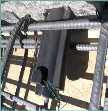
**Instalación:** El inserto plástico debe quedar ajustado y sellado, con el fin de evitar la entrada de elementos no deseados hormigón o lechada en su interior.
