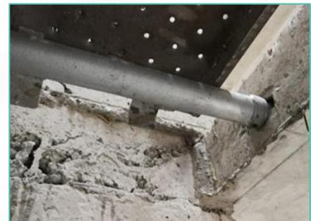
Introducida y bloqueada la viga de ascensor, la operación se repetirá en cada uno de los elementos que sean necesarios para garantizar la protección total.
