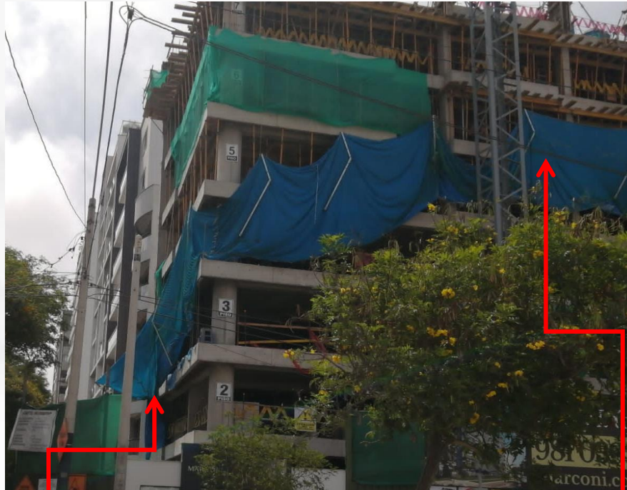
Posición inicial para elevación (PISO 03).
