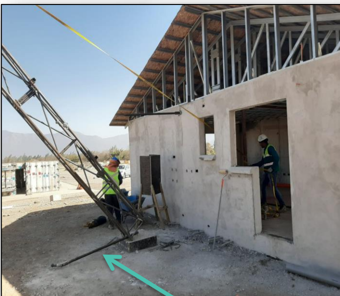
Tubo de arriostrado para garantizar eje y evitar volcamiento
