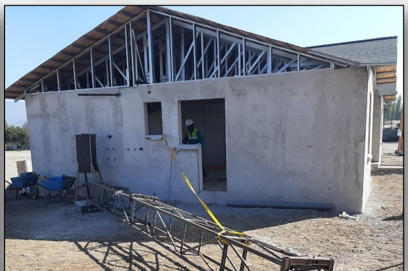
Pilar torre desmontado
