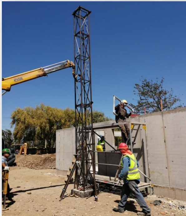
Posicionamiento de pilar pieza de 8 m. Con ayuda de grúa pluma.
