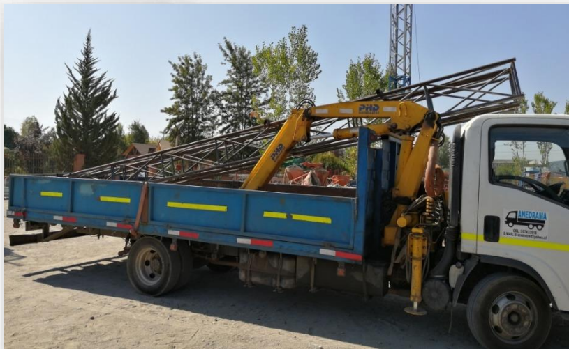
Traslado de pilar torre para líneas de vida en una pieza de 8 m. de altura
