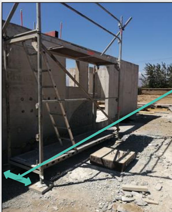
Distancia de separación de la base: 110 cm desde el eje del cuadrado de la base al muro.
