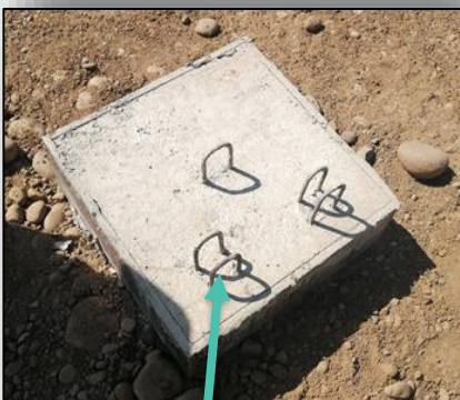
Orejetas para fijación del pilar
