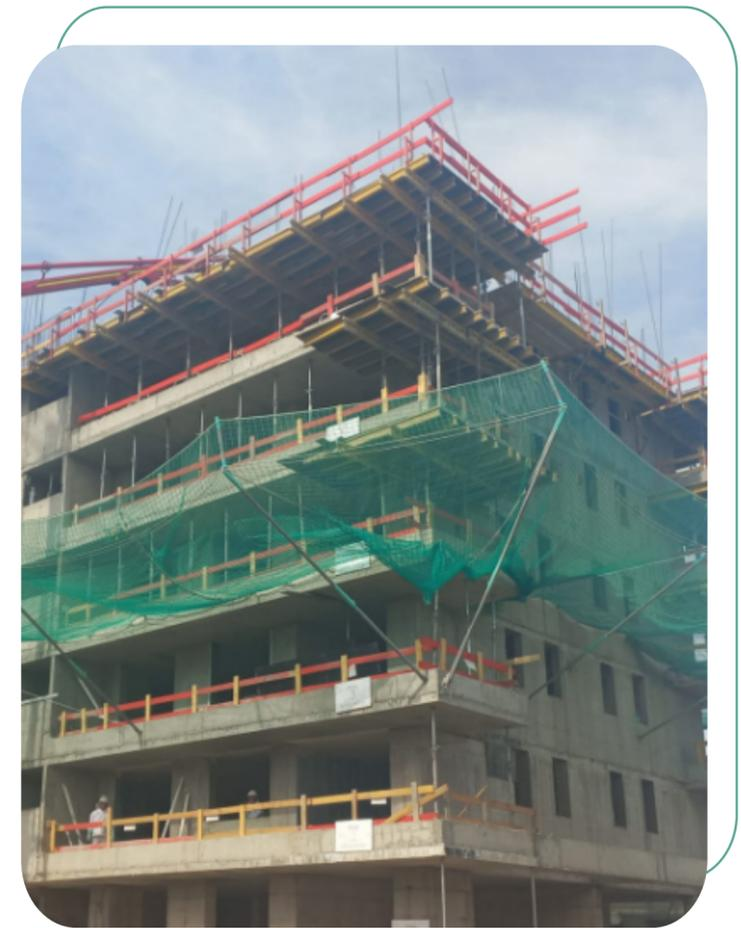
Nuestro sistema de protección anticaídas Bandeja "Tipo T", se encuentra patentado. Cuenta con memoria de cálculo, manuales y está diseñado para dar cumplimiento a la norma EN1263. Además de todos los elementos que la componen, se encuentran certificados.
