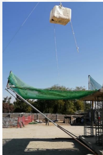
Imagen ensayo de carga
