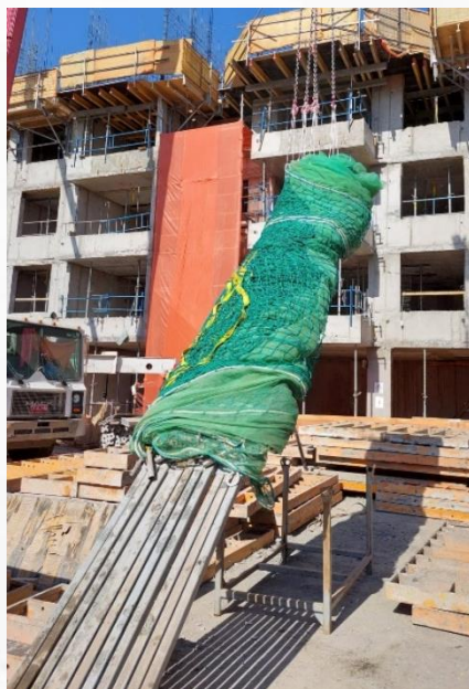
imágenes reales de elevación del sistema de red tipo "T"
