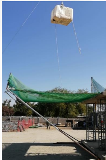
Imagen ensayo de carga
