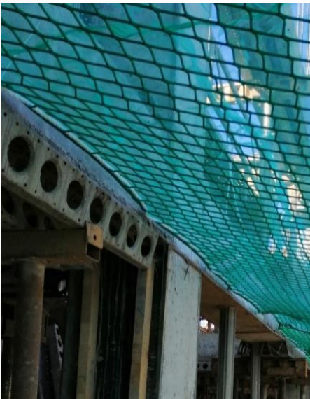
Ubicación de los omegas de \varnothing 8mm para sujeción de red en losa designada para instalación.
