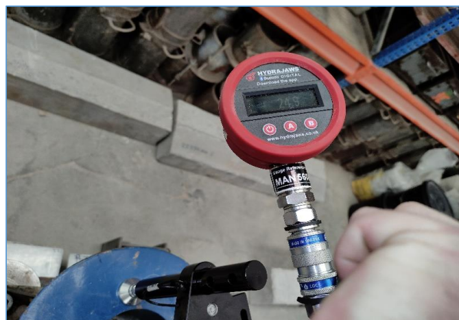
Ensayo de tracción "pull out" de anclajes PAT50XX/A
