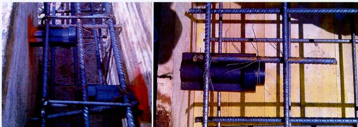
Figura 5. Colocación del Embebido JUSQ. Detalle de atado.
