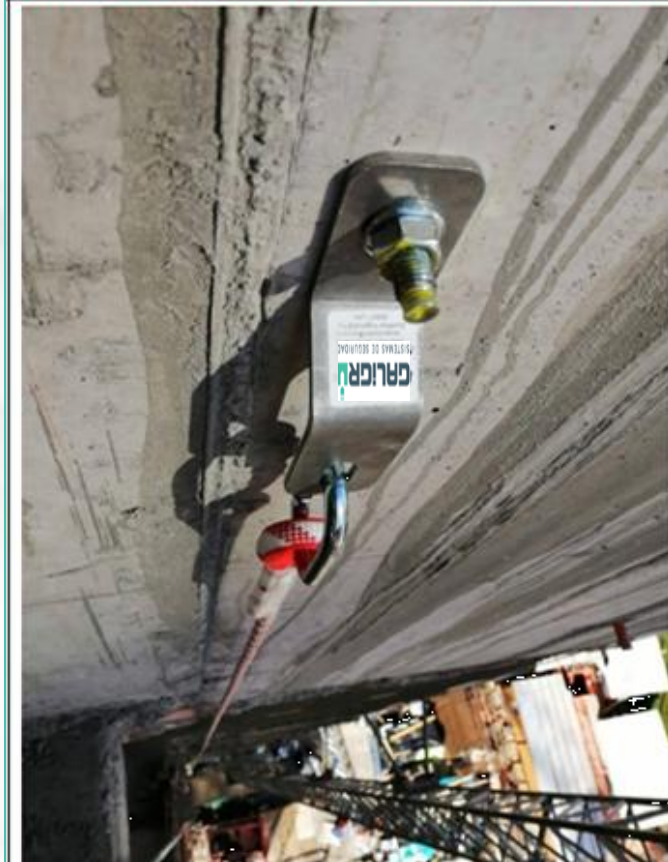
Anclaje para línea de vida vertical.
