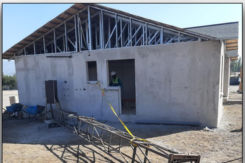
Pilar torre desmontado
