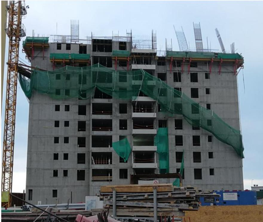
Para realizar la elevación consecutiva de los postes anclados y sujetos al punto de apoyo, se deberán soltar todos los postes de los puntos de anclaje BO-001a al igual que de los puntos del SOBAA
