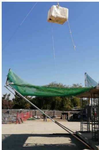
Imagen ensayo de carga
