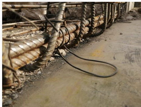
Ubicación de los omegas de \varnothing 8mm para sujeción de red en losa designada para instalación.
