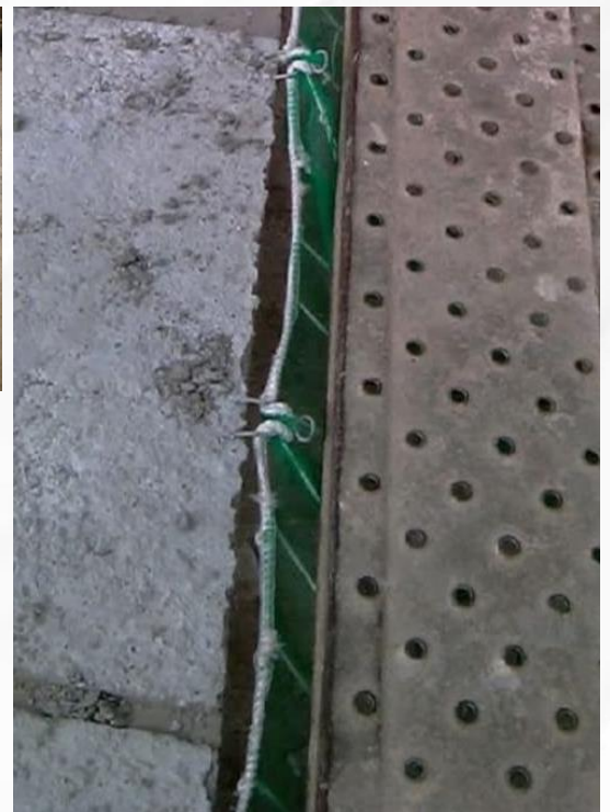
Ubicación de los omegas de \varnothing 8mm para sujeción de red en losa designada para instalación.
