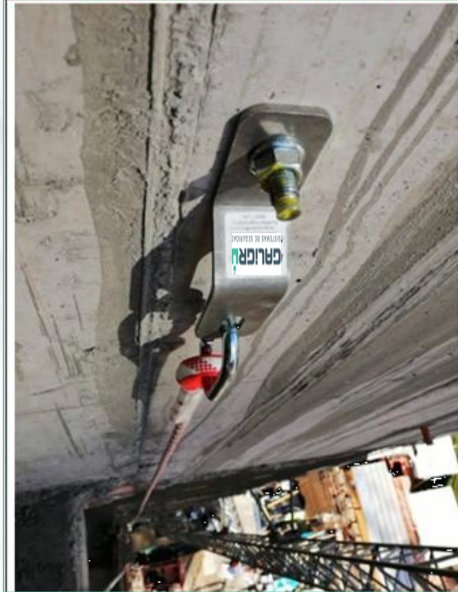
Anclaje para línea de vida vertical.
