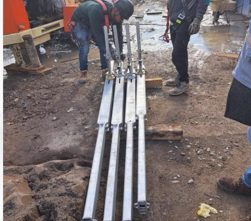
2. **Instalación de línea de vida en sistema PES02:** Tomar la línea de vida por el extremo con gasa y pasarla por el soporte superior del PES02 y así hacer todo el recorrido de la línea, dejando el únicamente el tensor y pasarla en dirección al otro poste. La línea pasa por el espacio que corresponda según la dirección donde fue ubicado el tensor, esta (línea) en su extremo con gasa deberá llegar al segundo pilar, hasta la parte central de este para ser bloqueada por el perno de seguridad.
